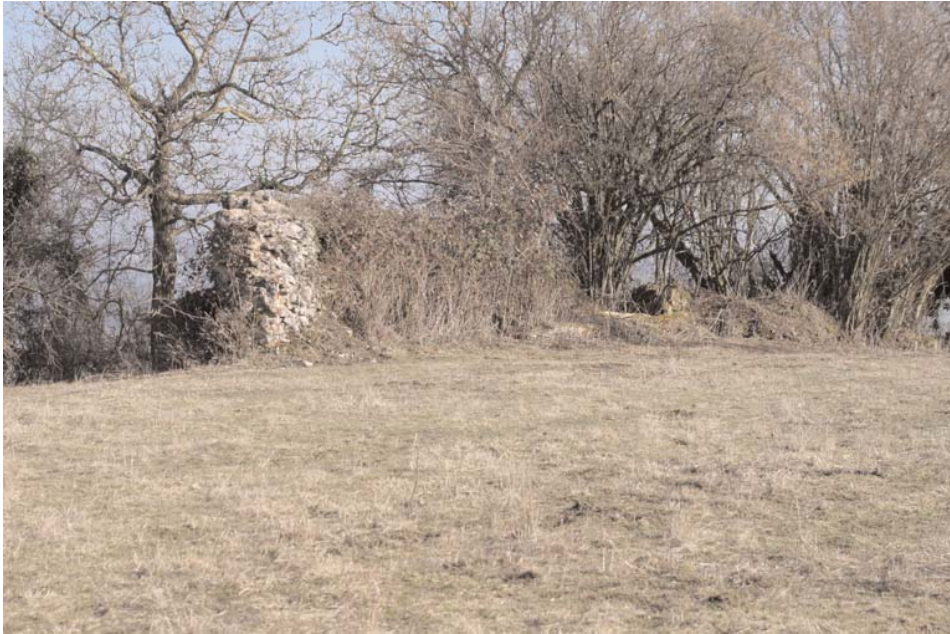
Vestiges du rempart est.
